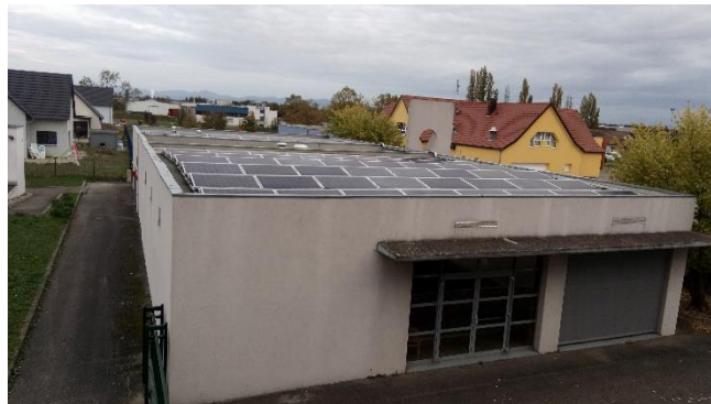
Photo 2 : panneaux photovoltaïques sur le toit du dojo
